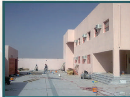
إنشاء مبنى مدرسة ابتدائية النباج - طبرجل
